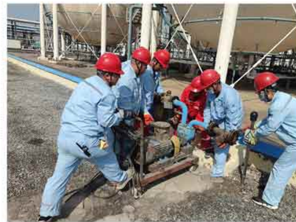
图为罐罐班人员把移动式抬运3#罐区内为检罐注水做准备
